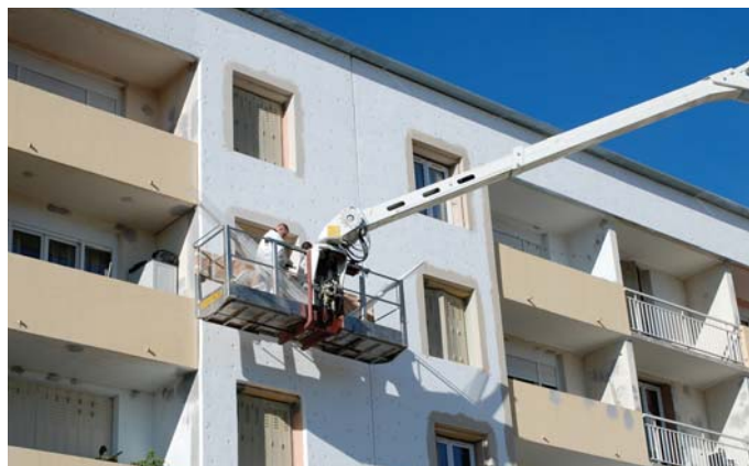
L'isolation par l'extérieur améliore la performance thermique des bâtiments et permet aux locataires de réduire leur facture de chauffage.
