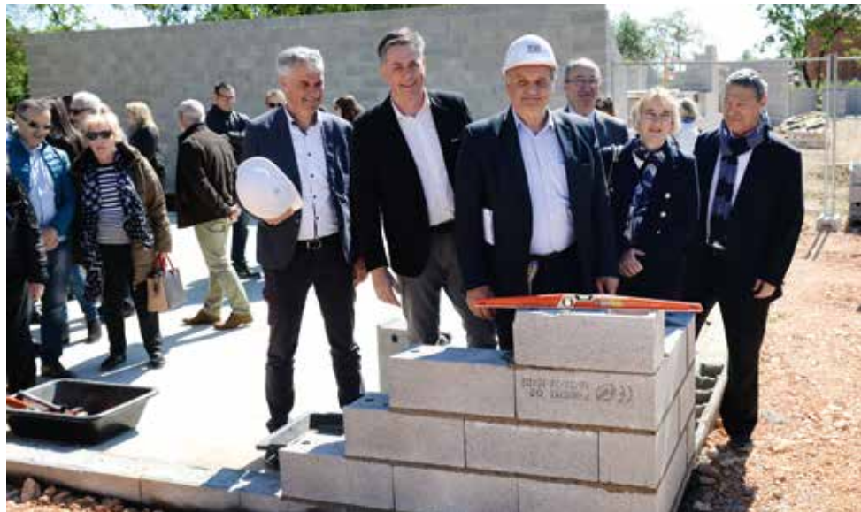
Dans la future salle commune, les élus ont lancé la construction de la résidence de Silhol, adaptée et réservée aux seniors.
