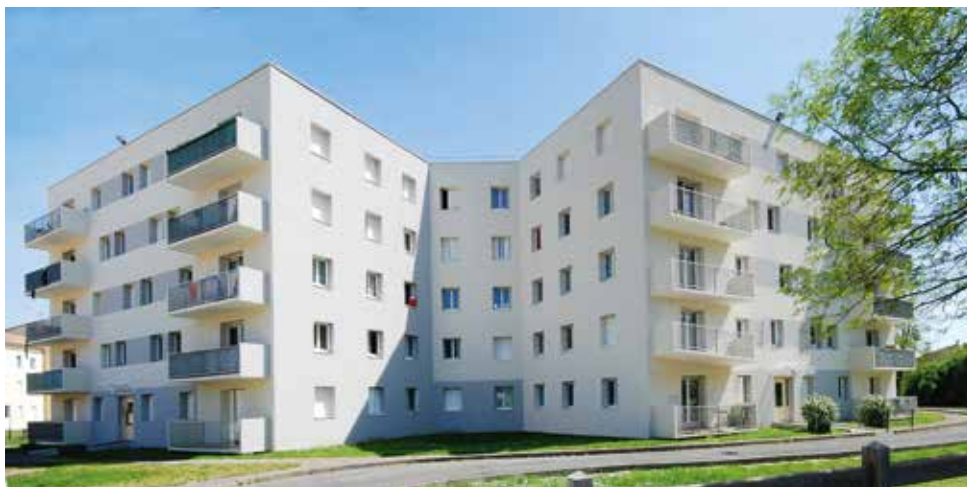
Des nouvelles façades à Rochebelle, pour une meilleure isolation en été comme en hiver.
