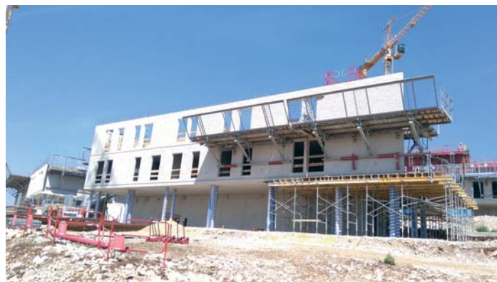
Les travaux extérieurs seront terminés à la fin de l'année.
