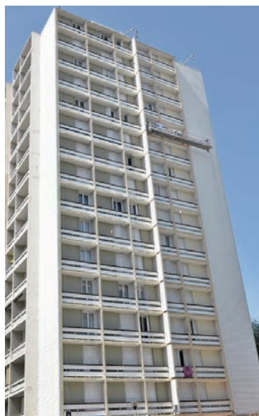
Au 53, Grand'rue Jean Moulin, les ouvriers rénovent la façade sur les 16 étages.
