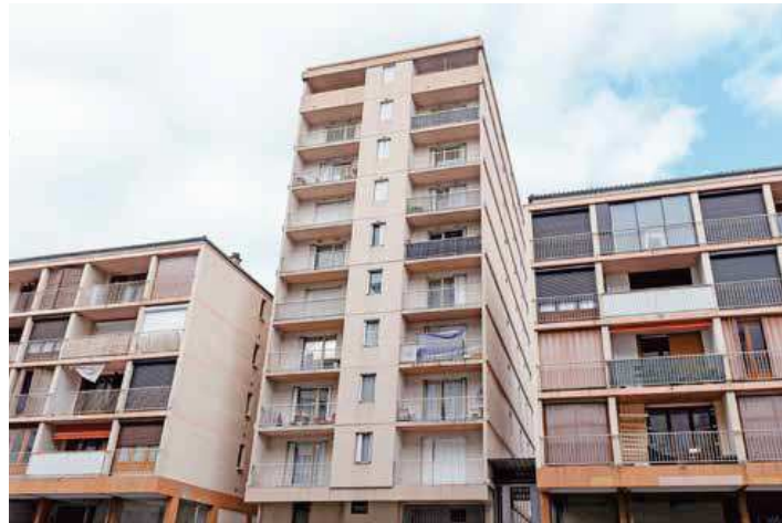
Le confort et les performances énergétiques de la résidence Le Villeneuve vont être améliorés grâce à un investissement de plus de 1,7 M€.
