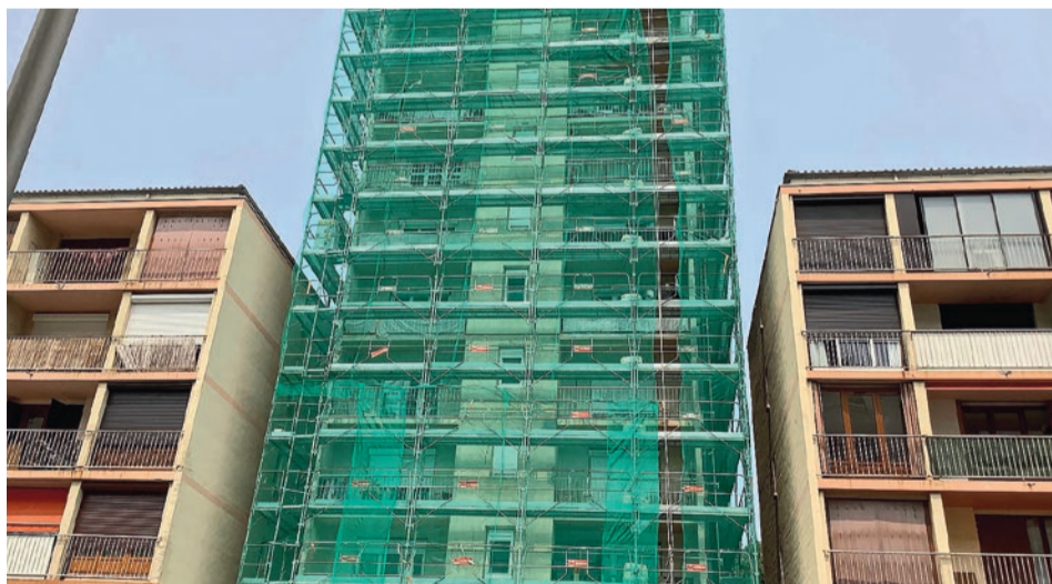
D'ici la fin de l'année, la rénovation du Villeneuve sera terminée.
