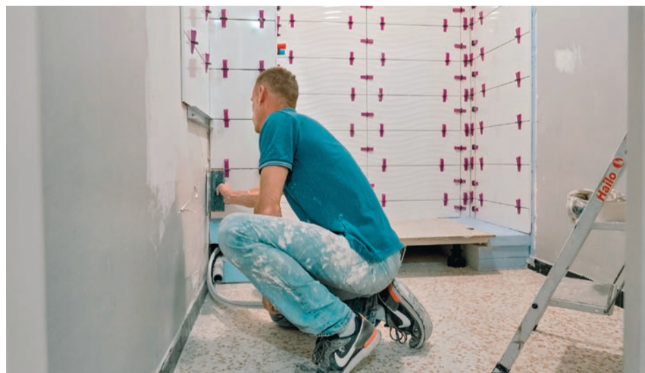
Dans la résidence des Aubépines à Alès, les 48 logements auront été rénovés d'ici la fin janvier 2024.
