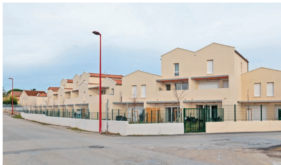
Sur le chemin de la Cave, à Ribaute-les-Tavernes, cette toute nouvelle résidence compte 27 logements, du T2 au T4.
