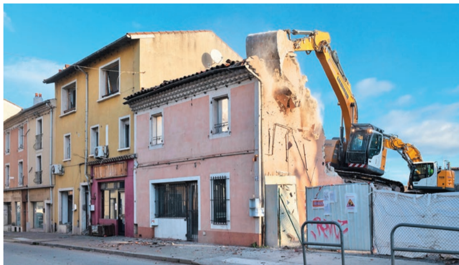
En décembre 2023, la bâtisse au numéro 39, rue du Faubourg du Soleil, a été détruite. Un nouveau bâtiment devrait sortir de terre pour être livré fin 2025.
