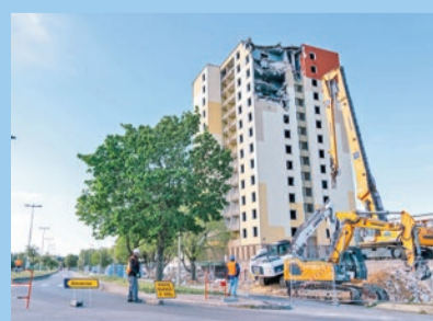
Le 22 avril, le premier coup de pelle a été donné pour démolir la tour du 23, quai du Grabieux, à Alès.
