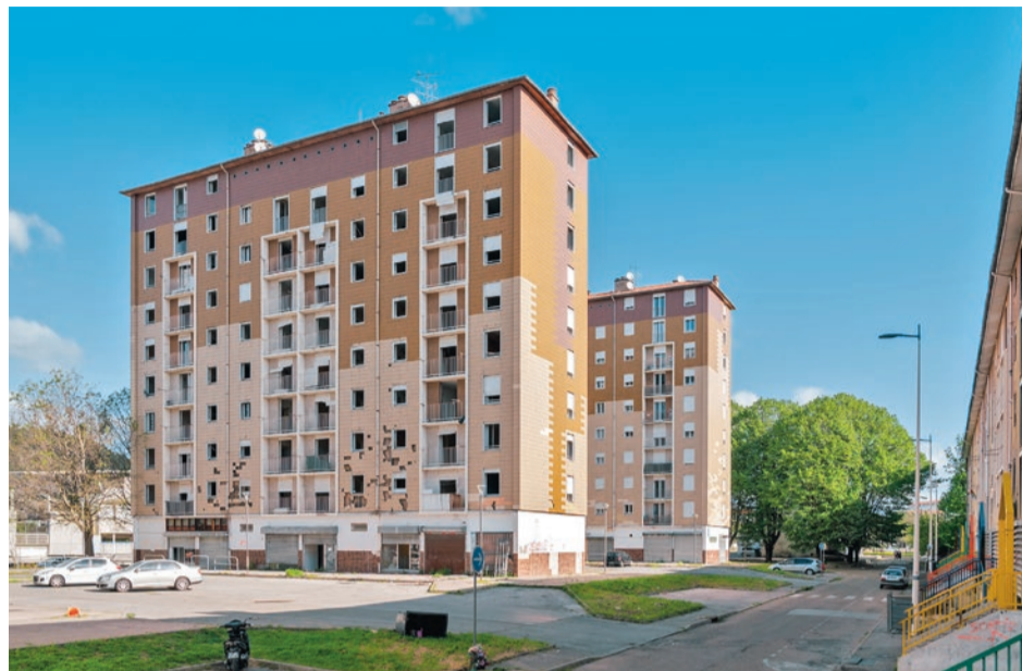
À Alès, dans le quartier des Prés-Saint-Jean, des immeubles vont être démolis dans la rue Sully Prudhomme.
