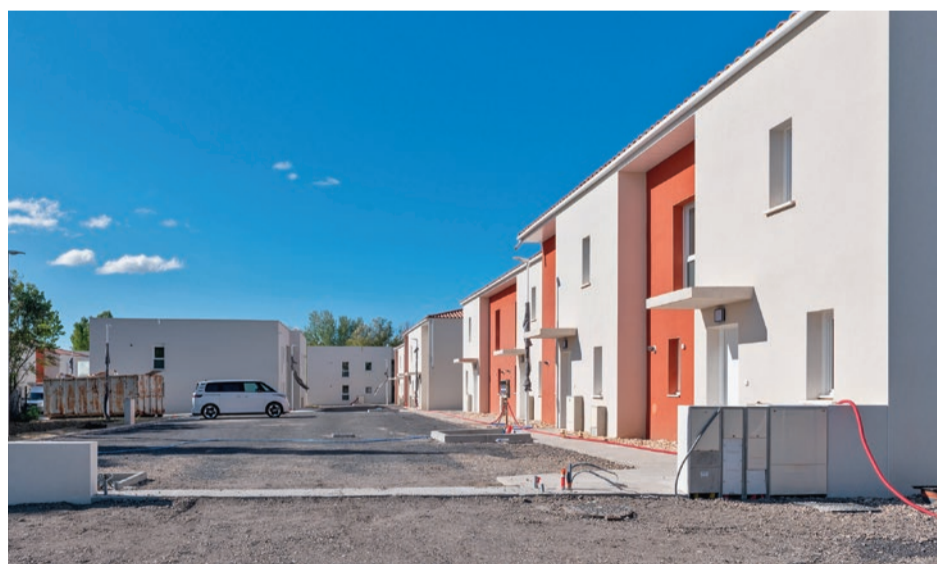
En septembre et en octobre, les dernières finitions ont été apportées à cette nouvelle résidence sécurisée.
