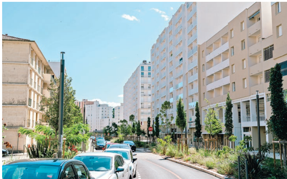
Les logements ont été rénovés, que ce soit avec la pose d'isolation thermique par l'extérieur ou par diverses interventions de réhabilitation dans les appartements.
