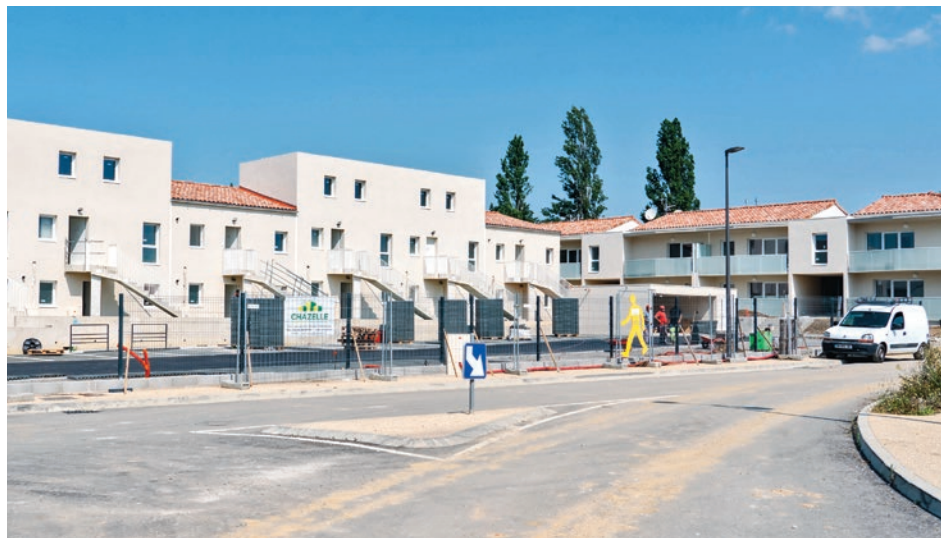
Logis Cévenols va examiner la totalité de son parc immobilier pour déterminer les projets prioritaires à mener, comme celui réalisé à Saint-Julien-les-Rosiers, permettant de donner vie au cœur du village.
