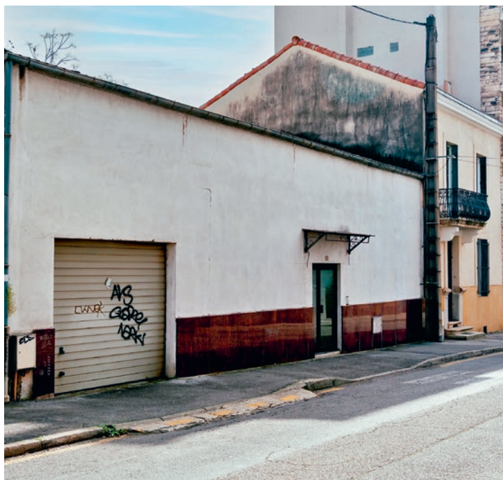
Le bâti existant au n°11 du boulevard Anatole France sera démolé avant la construction d'un immeuble de quatre étages.
